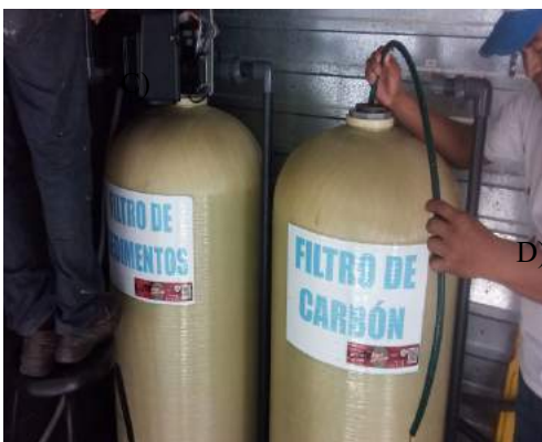
Figura 3. Desensamble del filtro de sedimento y carbón activado de la PPAITSM
