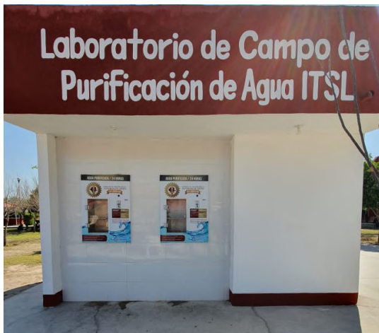
Figura 1. Planta purificadora del ITSL
