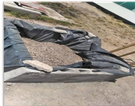
Figura 1. Elaboración del Humedal y colocación de sustratos
