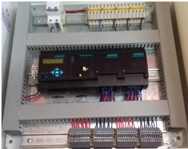
Figura 5. Vista del Medidor Terminado de Cablear.
