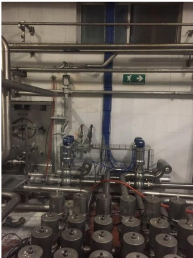
Figura 7: Clúster conectado a válvulas Mixproof
