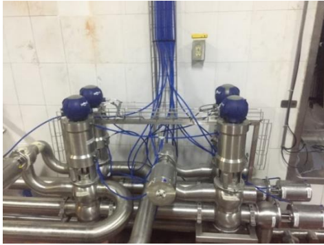
Figura 5: Válvulas Mixproof
