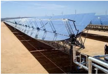
Figura 1. Configuración del colector solar parabólico
