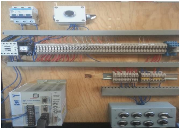
Figura 17 Instalación eléctrica
