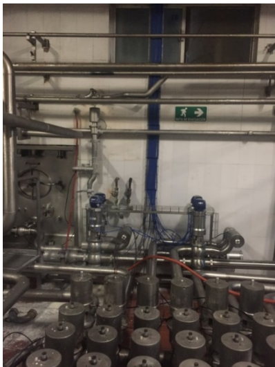
Figura 7: Clúster conectado a válvulas Mixproof
