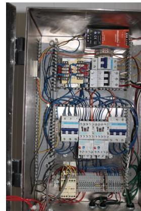
Figura 9. Tablero de control para bombas en tanque pulmón.
