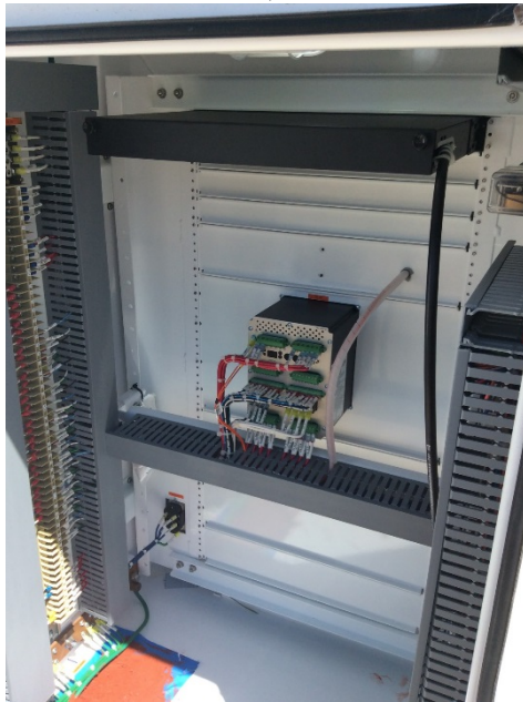
Figura 5. Instalación del monitor de transformador a) vista frontal del equipo b) vista posterior del equipo
