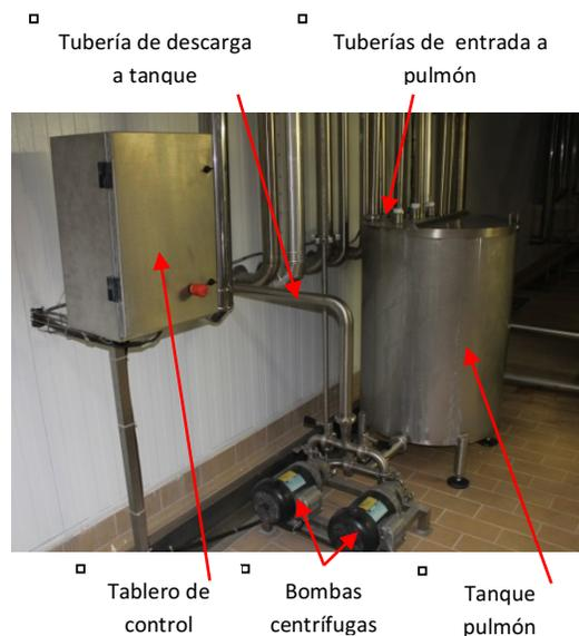
Figura 7. Tuberías de descarga hacia tubo cabezal
