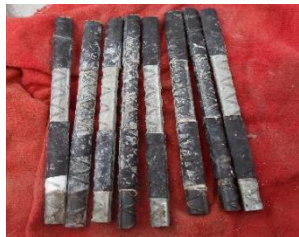
Figura 2. Preparación del acero utilizado como refuerzo.
