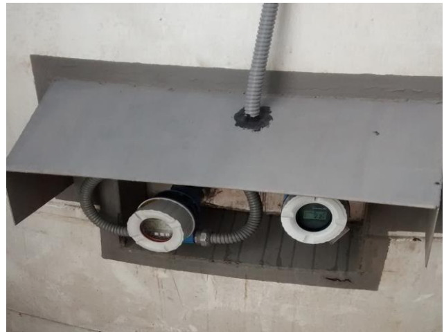
Figura 4. Ubicación de los sensores de nivel y temperatura en uno de los silos de almacenamiento.
