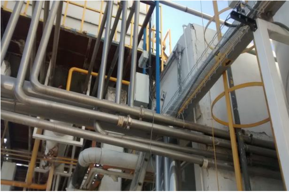
Figura 6. Gateway con su fuente de alimentación de 24VCD
