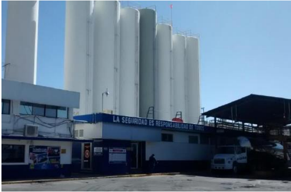
Figura 1. Silos de almacenamiento de leche en Transportadora de Alimentos S.A. de C.V.
