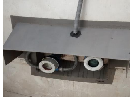
Figura 4. Ubicación de los sensores de nivel y temperatura.
