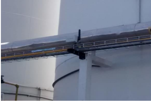
Figura 3. Ubicación del adaptador WirelessHART
