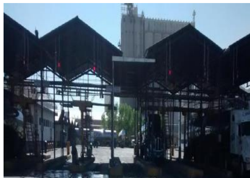
Figura 2. Carriles de descarga de pipas.
