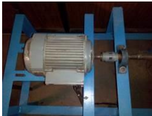
Figura 4. Conexión mecánica de las maquina eléctricas.
