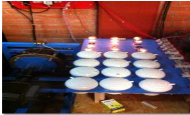
Figura 21. Encendido de cargas.
